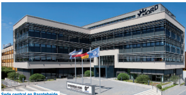
Sede central en Bargteheide
